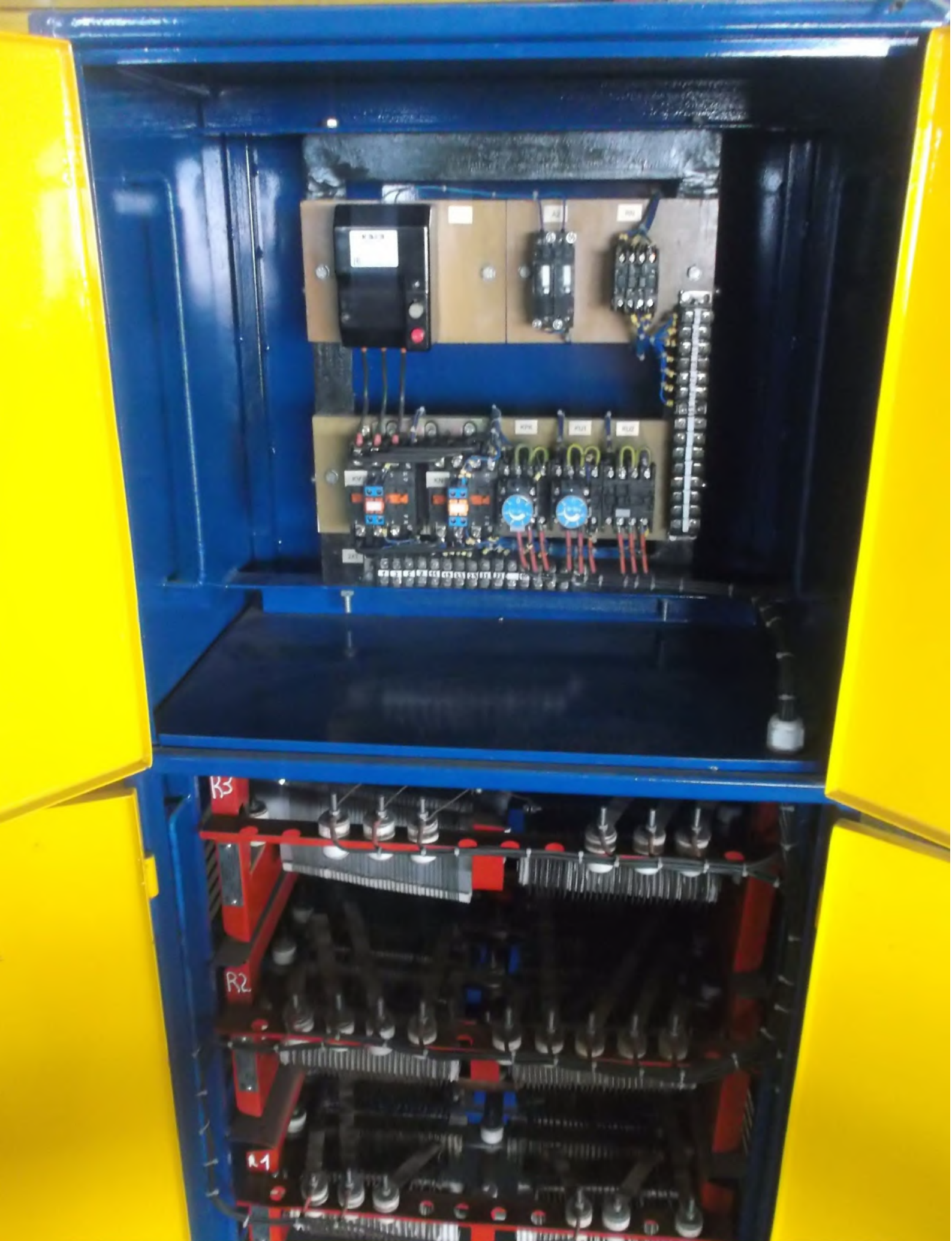
Шкаф управления передвижения тележки СТРМ5-02-АС на базе контакторной схемы
