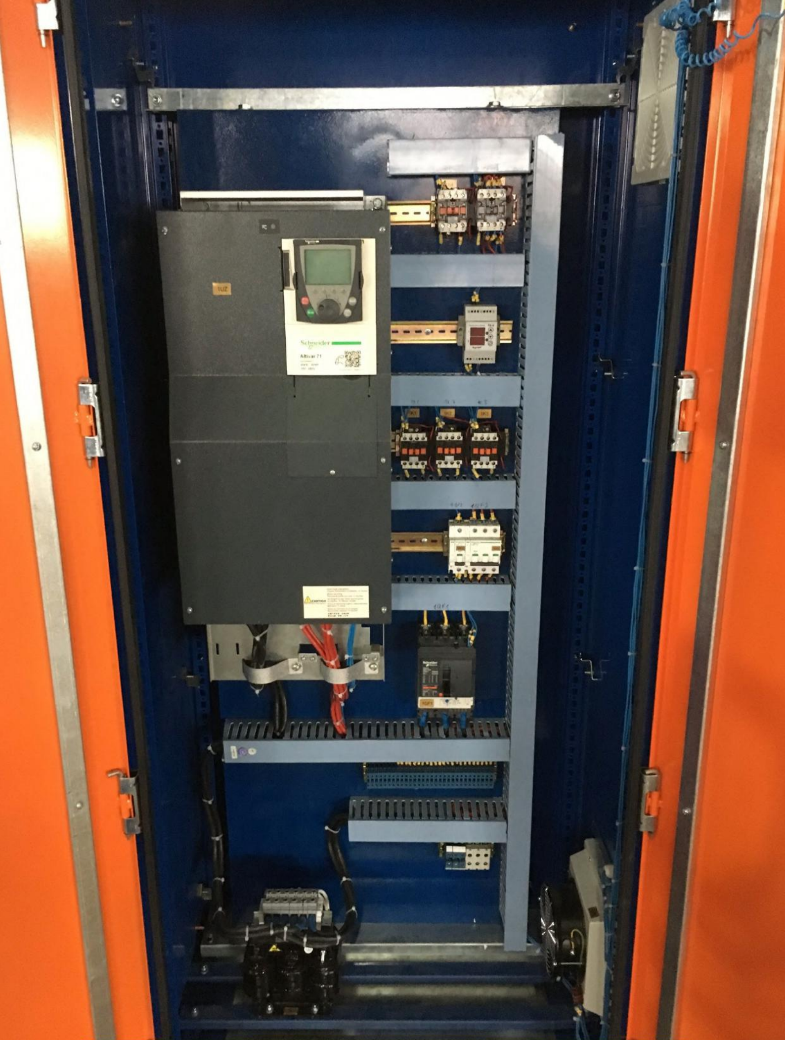
Шкаф управления подъемом SU-1-1x45-AC4 на базе преобразователя частоты Schneider Electric
